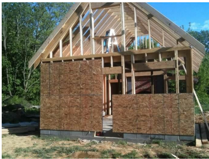
图3 预制木结构建筑
