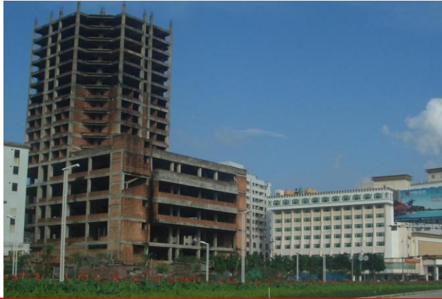
图 15 城市的伤疤——烂尾楼
